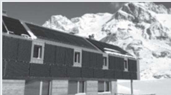
refuge, bâtiment moderne aux nouvelles normes environnementales et de sécurité. Les travaux sont désormais terminés et l'édifice flambant neuf, en bois massif avec panneaux photovoltaïques et capteurs thermiques intégrés, d'une capacité de 100 places, a ouvert ce printemps. L'inauguration du refuge aura lieu le 27 juin prochain. Quant aux anciens bâtiments, celui en pierre devrait servir au personnel du parc, aux gardiens et à des missions pédagogiques ; les bâtiments modulaires seront démontés.
